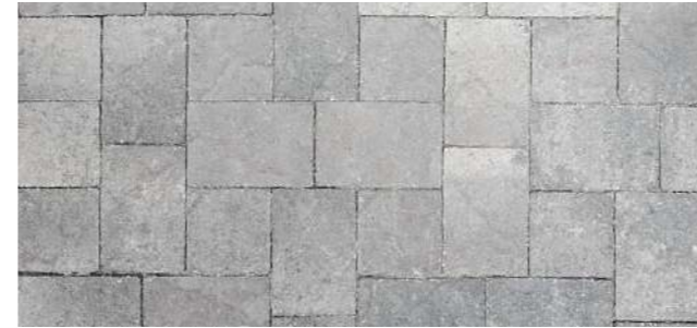
Korttelin sisäinen kävelytie suunnitellaan yhtenäiseksi samasta materiaalista ja sen suositellaan olevan kiveystä.
